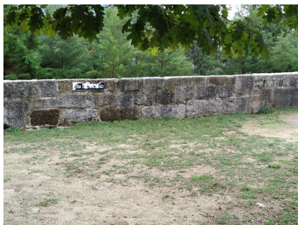
Figura 58 - Zona de Chincalhão (PL Arrochela)
