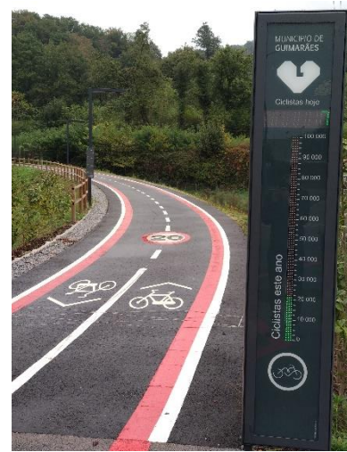
Figura 21 - Caminho pavimentado (Ecovia)
