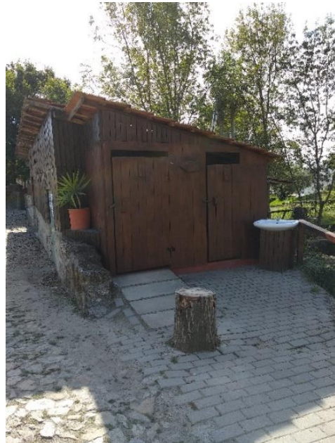
Figura 9 - Instalação sanitária (PL Moreira de Cónegos)
