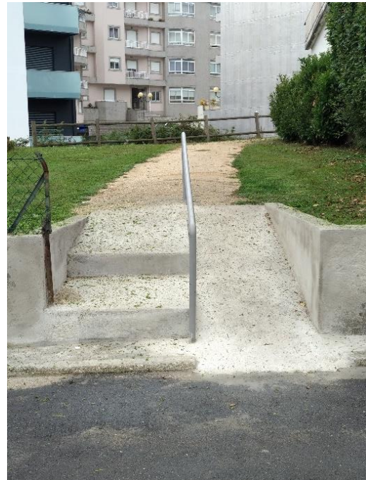
Figura 17 - Acesso com rampa (PL ARCOV)
